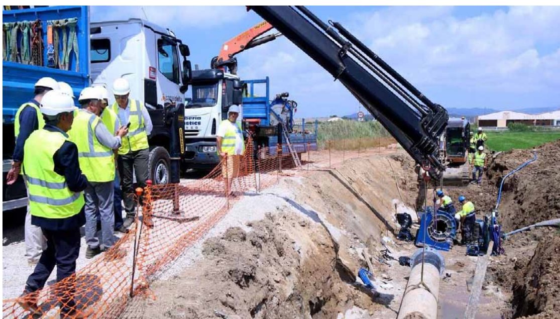
Responsables del Consorci d'Aigües de Tarragona (CAT) visitan las obras. / JORDI MARSAL / ACN
